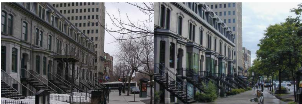
Façade avant l'intervention
