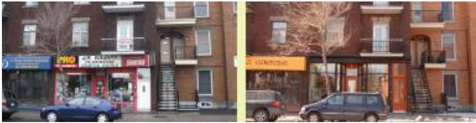
Vitrines commerciales avant l'intervention
