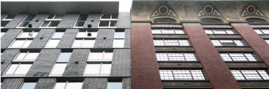
Le nouvel édifice Unity 2
